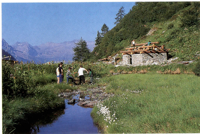
I lavori di ripristino della Baita Lavanech.
